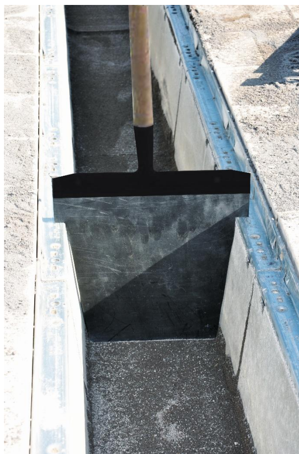
Slika: Lopatica za niveliranje podloge supstrata (ovdje s DRAINFIX CLEAN FSU)
