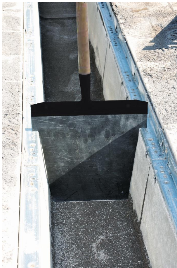
Obr: Nivelační pomůcka pro srovnání substrátu (zde pro DRAINFIX CLEAN FSU).
