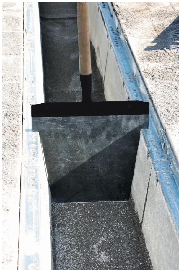
Ábra: szintező eszköz a fölösleges szubsztrátum eltávolítására (itt a DRAINFIX CLEAN FSU esetében)
