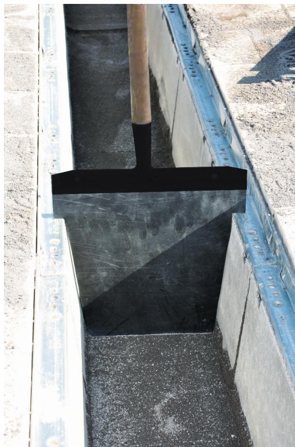
Fig.: dispositivo di livellamento per il substrato filtrante (qui per DRAINFIX CLEAN FSU)
