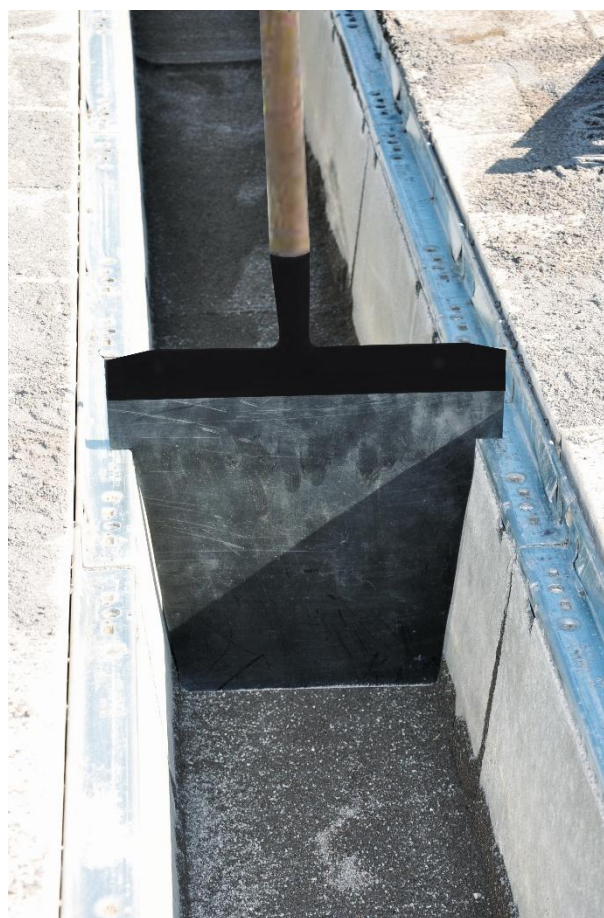
Rys: Urządzenie poziomujące do poziomowania podłoża filtracyjnego (tutaj z kanałem DRAINFIX CLEAN FSU)
