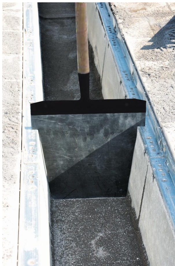
Fig.: Scula de nivelat/curatat strat filtrant (aici cu DRAINFIX CLEAN FSU)
